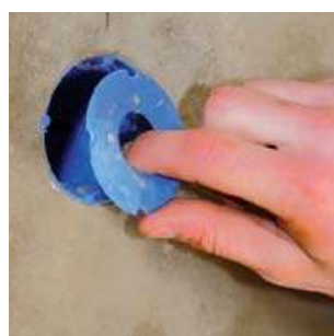
8. Wyrzucić dekielek i puszkę gotowa do zamocowania osprzętu (w układzie prostokątnym puszkę posiada słupki do wkręcenia śrub osprzętowych).
