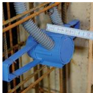
6. Zamocowana puszkę pozwala na zastosowanie głębokości betonu do 60 mm.
