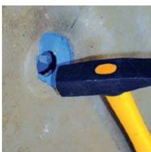
7. Wybić dekielek po wyrównaniu ściany.
